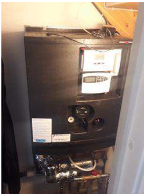
Povezava stavbe z omrežjem daljinskega ogrevanja z izmenjevalnikom toplote
