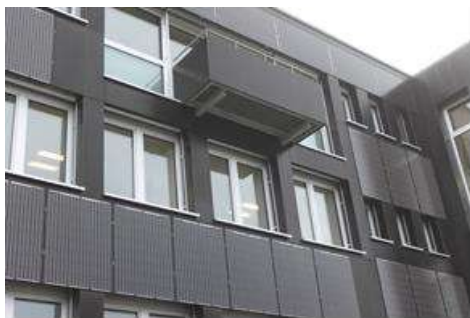
Fotonapetostne plošče, integrirane v fasado stavbe
