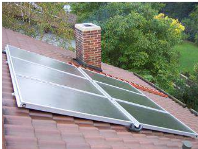
Sončni kolektorji, nameščeni na strehi enodružinske hiše
