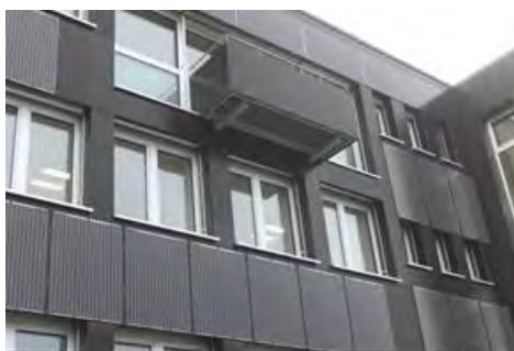
Fotonapetostne plošče, integrirane v fasado stavbe
